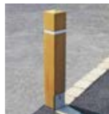
Příklad řešení zákazu vjezdu pomocí sklopných dřevěných patníků (regulovaný režim pouze pro průjezd obsluhy území).
