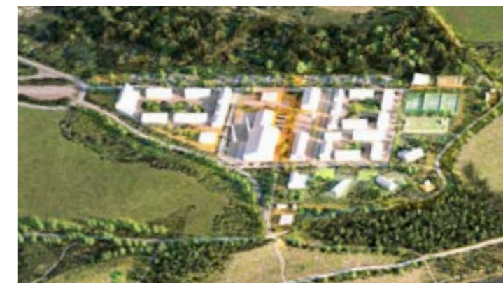
Pohled na revitalizovanou halu Ocelárny s okolním veřejným prostorem a zástavbou
