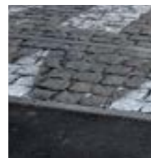
Příklad řešení křížení obsluhy a rekreačního okruhu - změna povrchu, zpomalovací obrubník.
