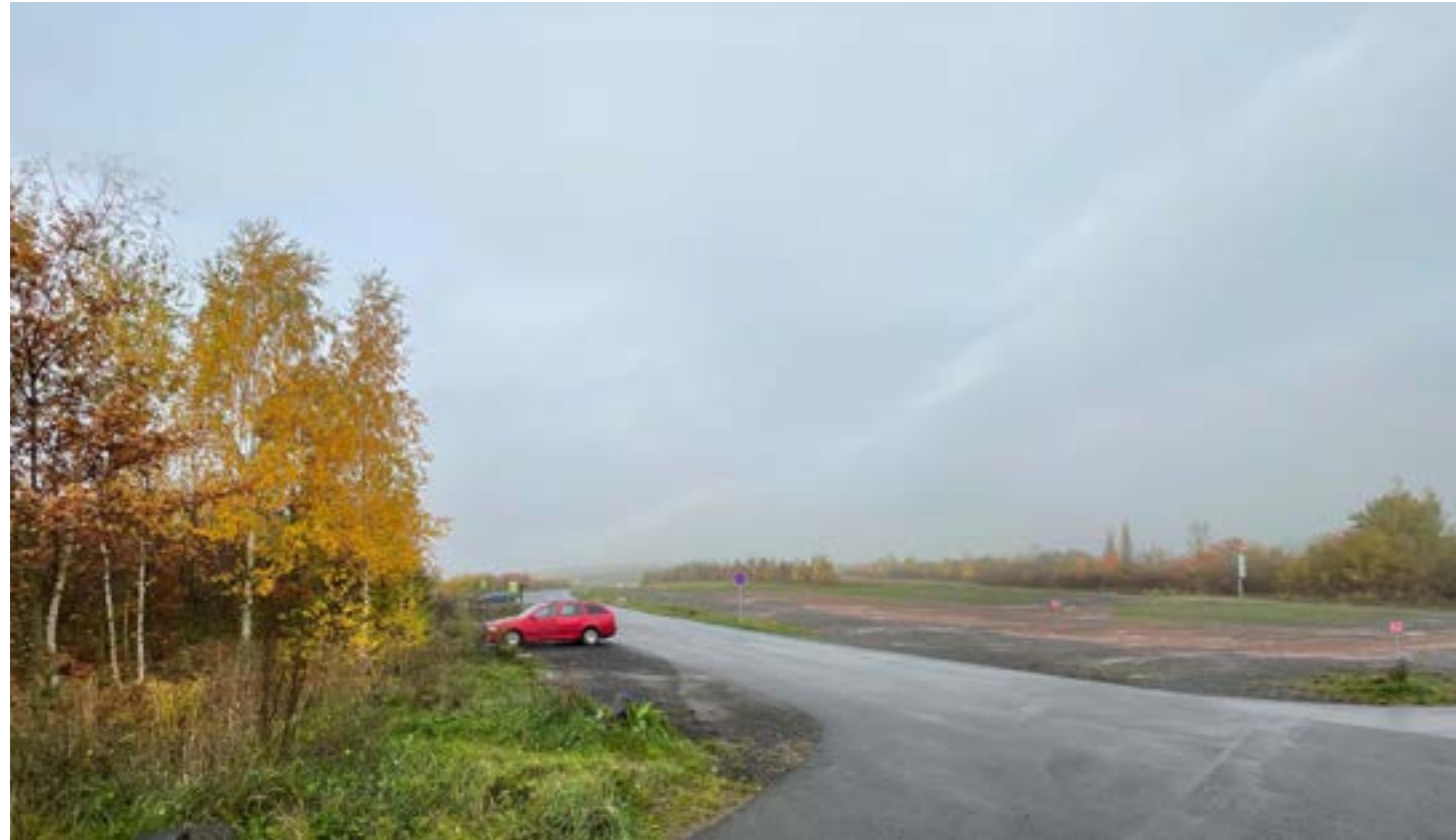
Vstup Hrbovice - současný stav
