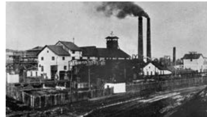
Ocelárna – slévárna Chabařovice, 1910
