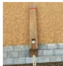
Příklad řešení zákazu vjezdu pomocí sklopných dřevěných patníků (regulovaný režim pouze pro průjezd obsluhy území).
