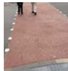
Příklad řešení křížení obsluhy a rekreačního okruhu - změna povrchu, zpomalovací obrubník.
